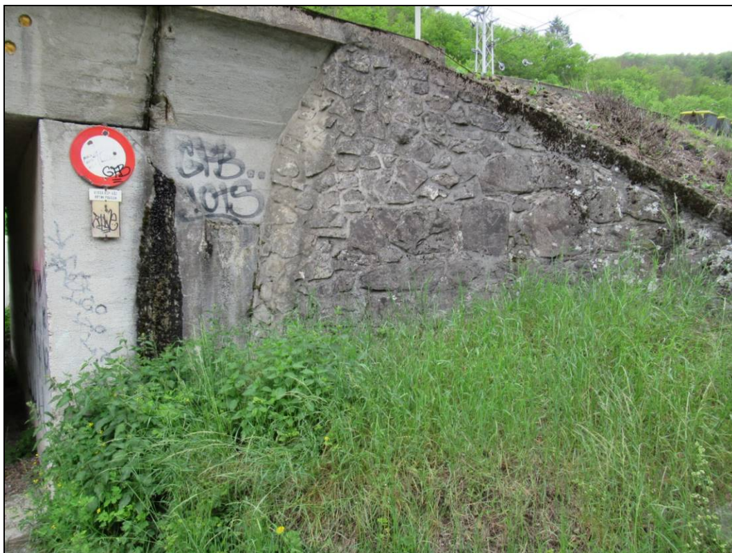
Obr. č. 9 – pohled na pravé křídlo opěry Blansko. Na této straně také dochází k průsakům dilatační spárou mezi pravou částí NK a opěrou v místě závěrné zídky.
